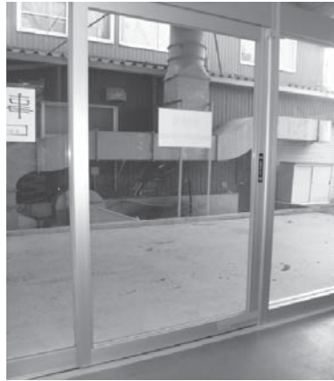
②会社の出入口を車いすで移動可能なように自動ドアに改修
